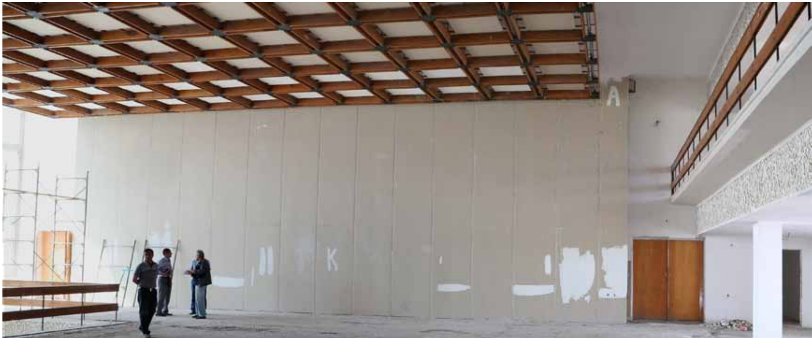
Общий вид стены, на которой была нанесена роспись Ч.Ахмарова. Бухара. Реконструкция зала бывшего Дворца газовиков. 2017г.
